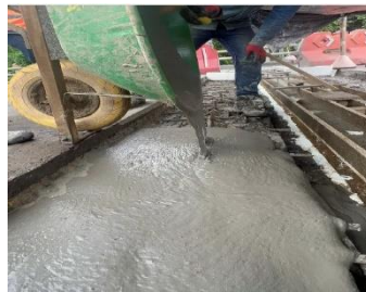
Fundida o vaciado del UHPC en bloques de nivelación y menzulas para reducir la apertura
