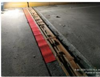
Reforzamiento de membrana anti fractura
