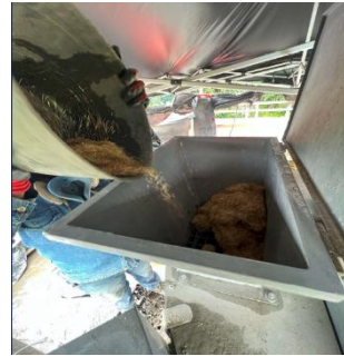
Mezclado de micro fibras estructurales f_y=2850\text{MPa} , en un cuantía de 156\text{kg/m}^3
