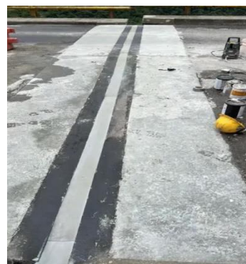
Intalación de junta tipo PolySet, sobre bases en UHPC
