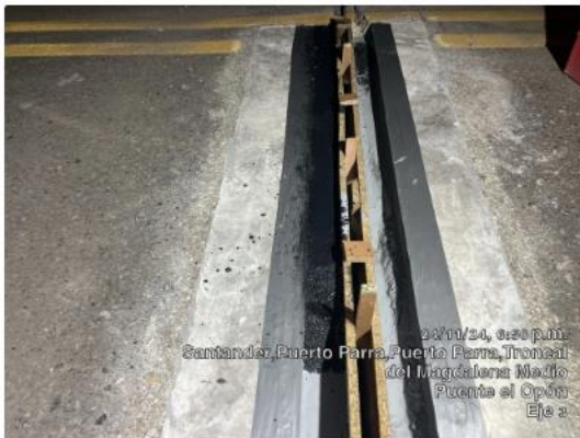
Instalación y fundida de concreto elastomérico PlyKrete de color Negro
