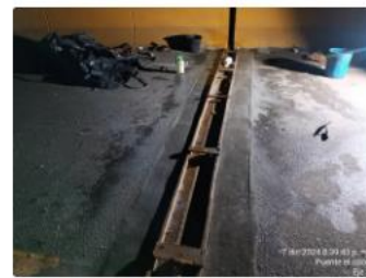
Bloques de nivelación con membrana anti-fractura y concreto de ultra alto desempeño UHPC
