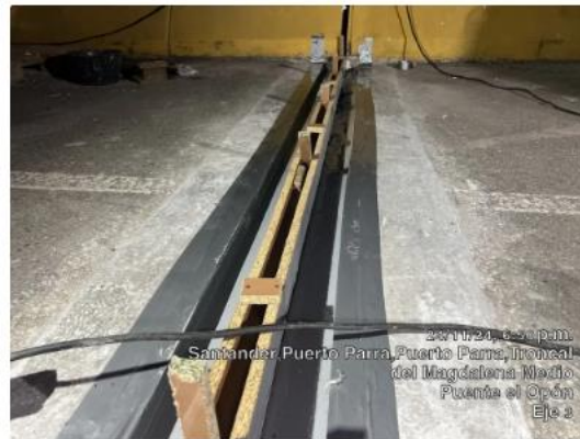
Protección de cinta para no manchar el UHPC con el concreto elastomérico PlyKrete
