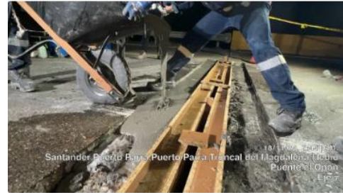
Fundida de bloques de nivelación en UHPC, mezcla con reología de mini Slup de 18cm de diámetro.
