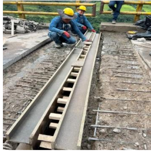
Preparación de la formaleta para negativos de junta tipo PolySet
