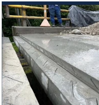
Desmoldaje de los bloques en UHPC
