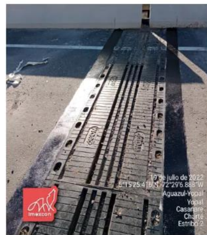
Imagen 13. Junta modular instalada con el sistema Ply krete en el proyecto 4G Villavicencio Yopal para el concesionario Covorient.
