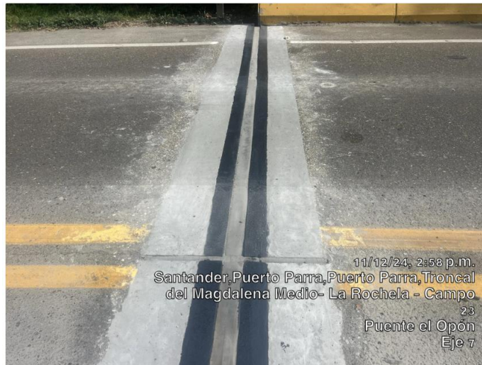
Junta terminada con sistema desarrollado por grupo Imexcon Latam., con bases en concreto de ultra alto desempeño UHPC y junta en concreto elastomérico y sello flexible tipo Polyset
