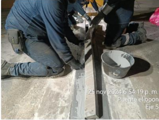
Instalación de sello impermeable y flexible Ply Seal
