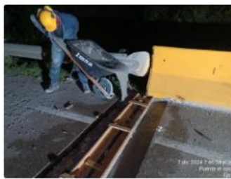
Instalación de concreto fibro-reforzado estructural UHPC
