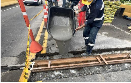
Fundida de bloques de nivelación en UHPC
